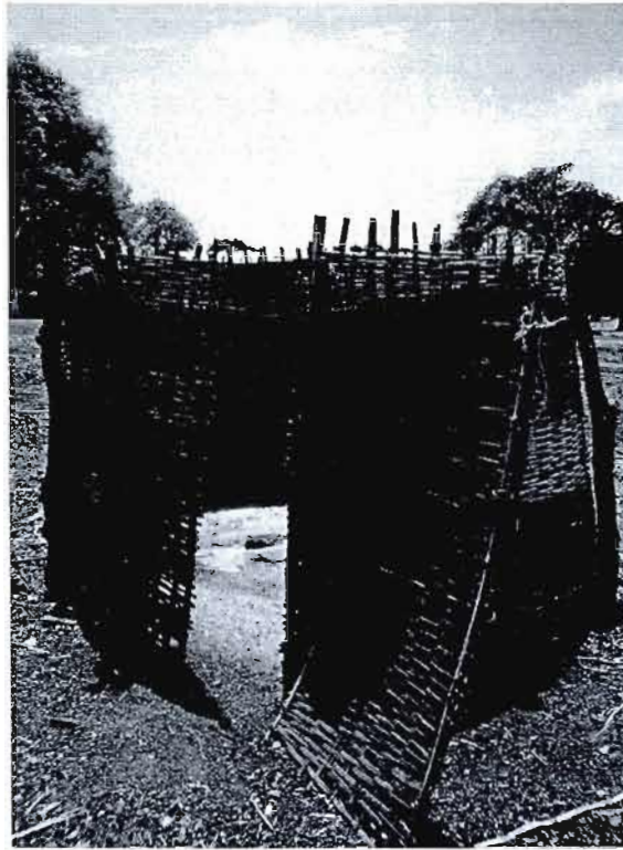
Figure 4.11 Construction d'une nouvelle latrine (Thiabédji, mai 2008)
