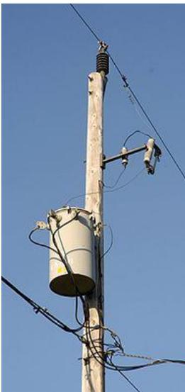
Dans les systèmes de haute tension (quelques kilovolts), un transformateur monophasé peut être utilisé pour générer une basse tension à partir du triphasé. En Amérique du Nord l'enroulement primaire est connecté entre une phase et le neutre, tel que sur la photo ci bas (transformateur de faible puissance monophasé).
